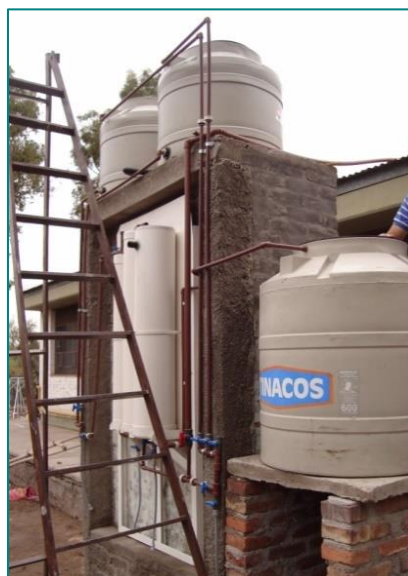
Figura N°9 Equipo de abatimiento de As en la escuela San José de Lavalle Fuente: Diario El Sol (22).
