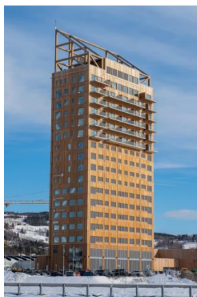
Figura 8: Vista de la torre
