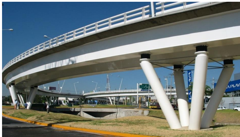
Figura 24: Vista del puente
