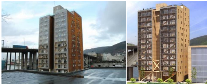
Figura 7: Vistas de los edificios
