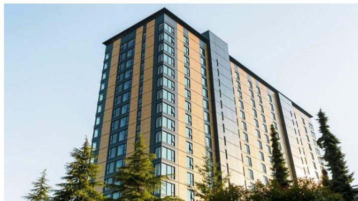
Figura 12: Brock Commons Tallwood House
