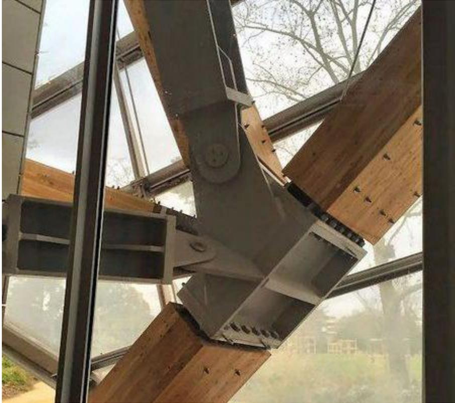
Como se puede apreciar, al estar las barras metálicas unidas mediante un solo remache, funcionan como articulaciones en ese plano. La unión propuesta es la siguiente:
