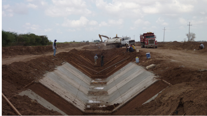
Figura 13: Construcción de un canal para riego
