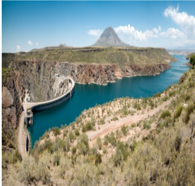
FIGURA 34. Presa de Agua del Toro.
