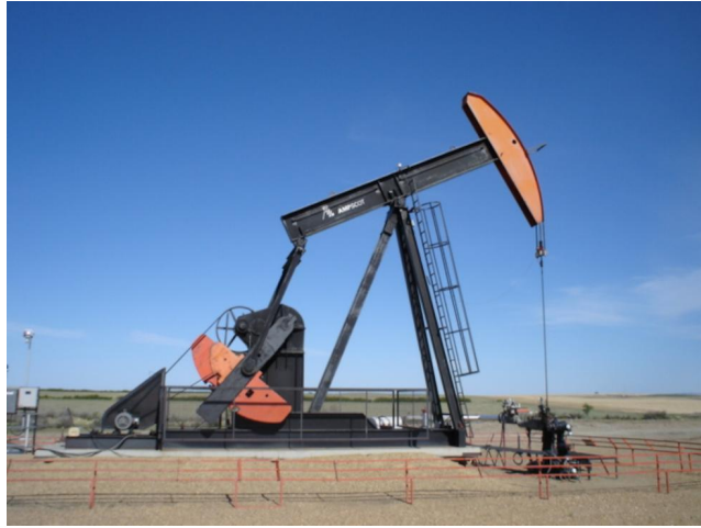
Figura 19: Equipo de bombeo de petróleo
