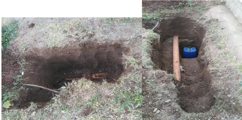
Figura 23. Espacio de trabajo para la intervención de la cañería. Pozo de muestreo, con la intervención realizada (Izquierda); descubrimiento inicial de la cañería (Derecha). Fuente: Elaboración propia.
