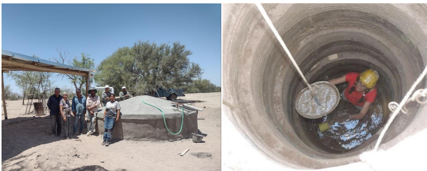
Figura 11: Tecnologías de acceso al agua, cisterna de placas (izquierda) y pozo excavado y calzado (derecha). Fotografías UST Campesina y Territorial
