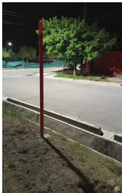
*Ilustración 27: Poste mal instalado en vereda opuesta.*
