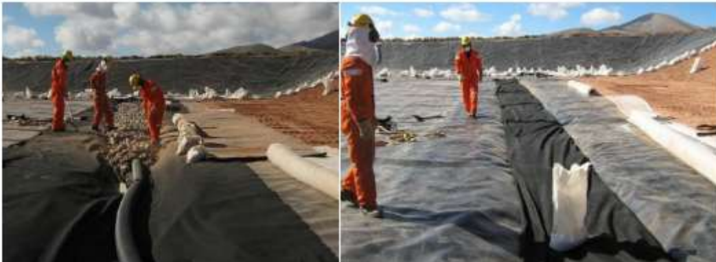
Figura 5.7: Colocación de una tubería para recolección de lixiviados
