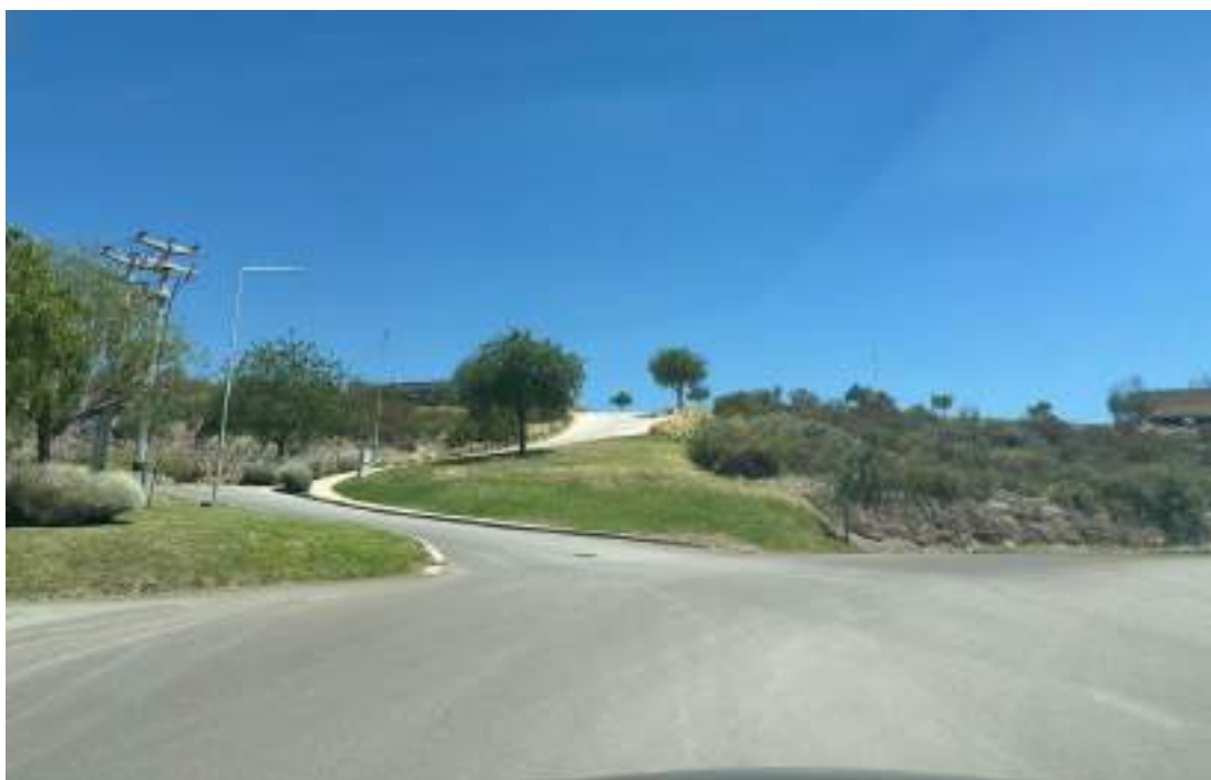
Figura N° 41: Trazado de calles adaptadas a las curvas de nivel
