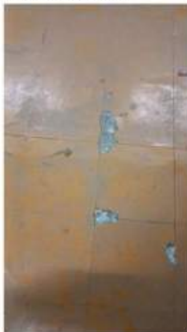
Levantamiento del suelo en el medio del local
