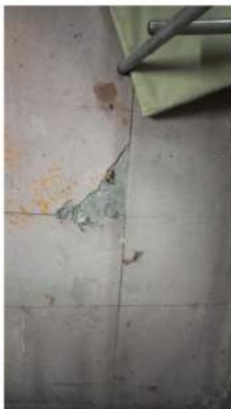
Desprendimientos y fisuras en el piso generados por hundimientos del suelo.
