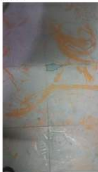
Suciedad y desprendimiento de piso vinílico
