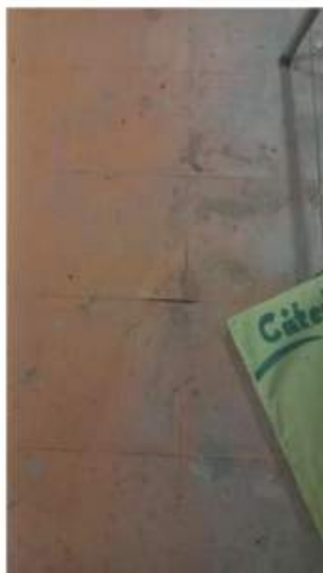
Desprendimientos y fisuras en el piso generados por hundimientos del suelo.
