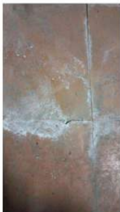
Desprendimiento de placas de EPS
