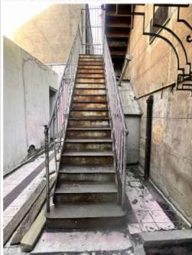
VISTA FRONTAL 1ER TRAMO
