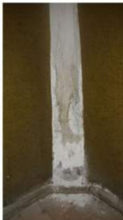
Suciedad y desprendimiento de piso vinílico
