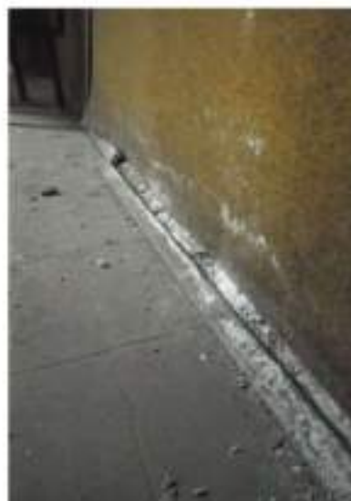
Eflorescencias y desprendimientos de zócalos
