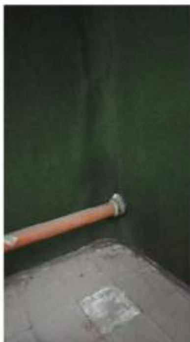
Desprendimientos del piso vinílico
