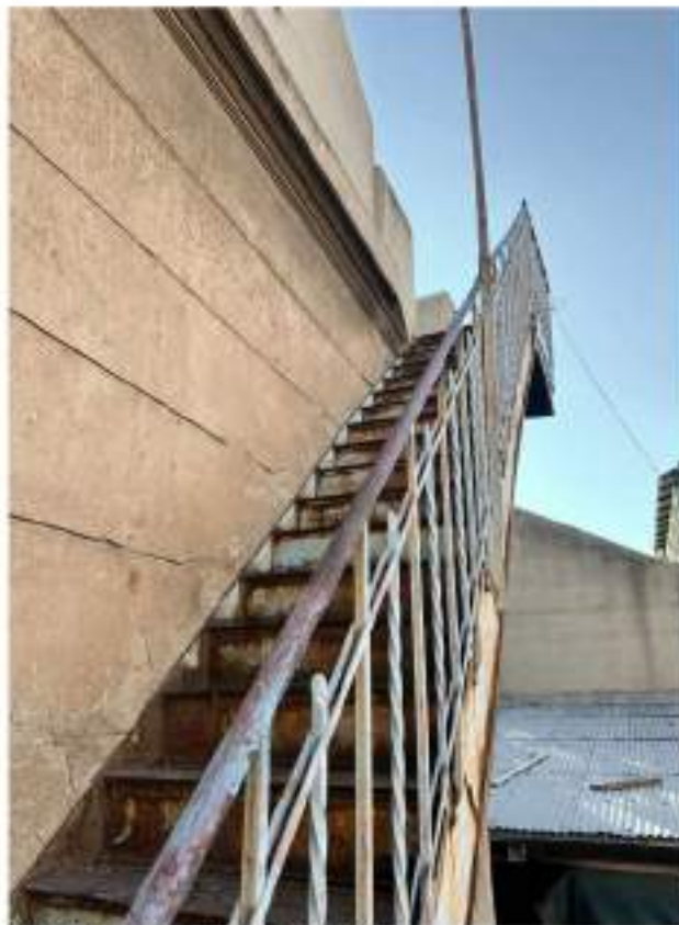
VISTA A 2DO TRAMO
