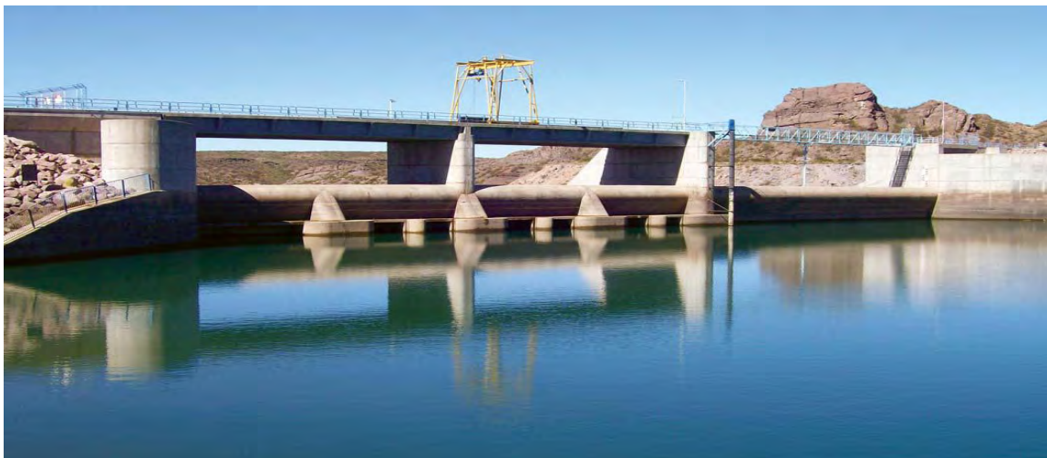
Imagen n° 12: Toma de la Central El Tigre
