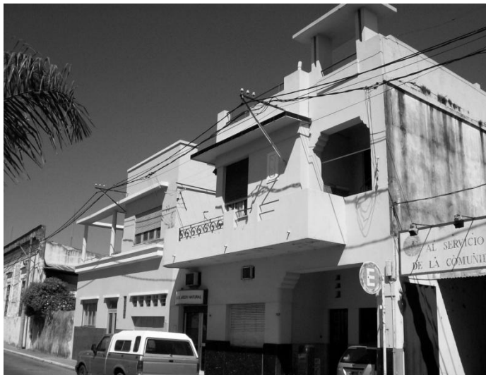
Figura 1. Plácido Martínez al 700. Conjunción de momentos históricos materializados en arquitectura, desde el colonial hasta la modernidad compartiendo modos de construcción de la ciudad.
