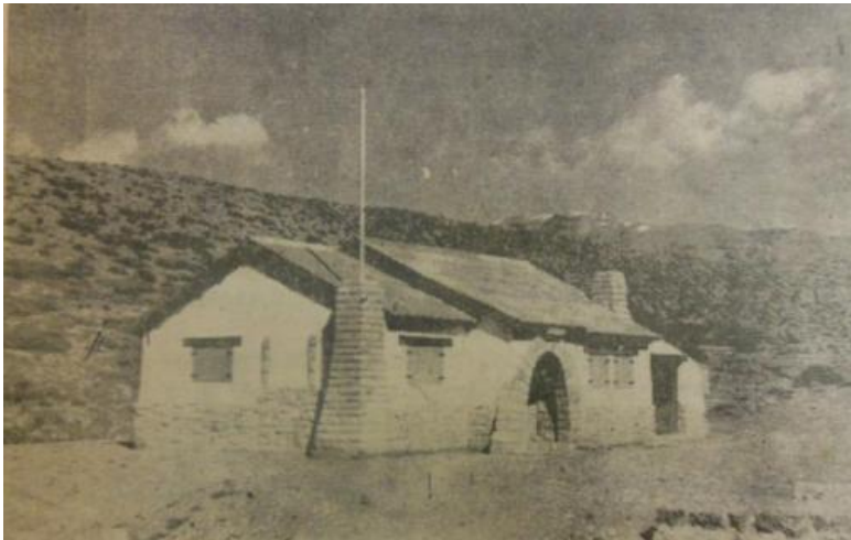
Figura 7: Prototipo construido en Calmuco.
