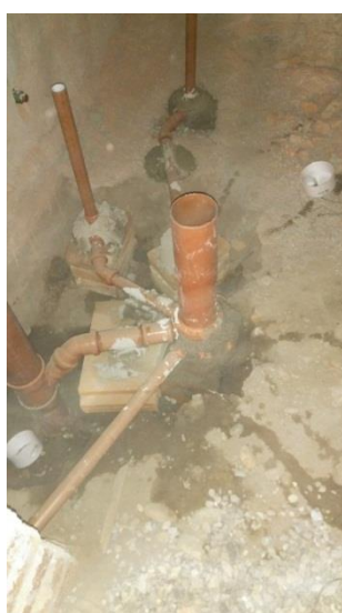
Imagen 28: Red interna de cloaca y prueba hidráulica
