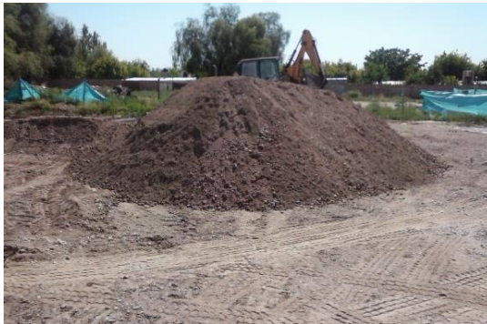
Imagen 21: Suelo estabilizado para relleno (izquierda). Terreno compactado (derecha)
