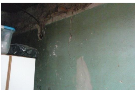
Imagen 3: Fisuras verticales a nivel techo y daño de humedad. Fisuras en dintel.
