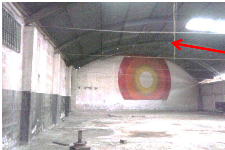
Imagen 6: Deformación en arco debido al arrastre del muro
