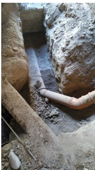
Imagen 28: Red interna de cloaca y prueba hidráulica
