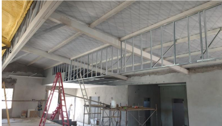
Figura 27. Colocación cielorraso.
