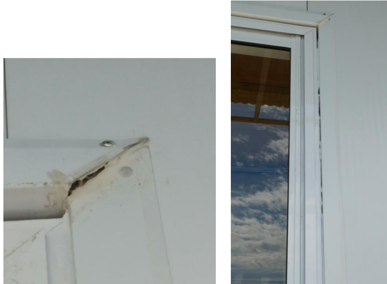
Figura 35. Mala terminación y sellado de carpintería.
