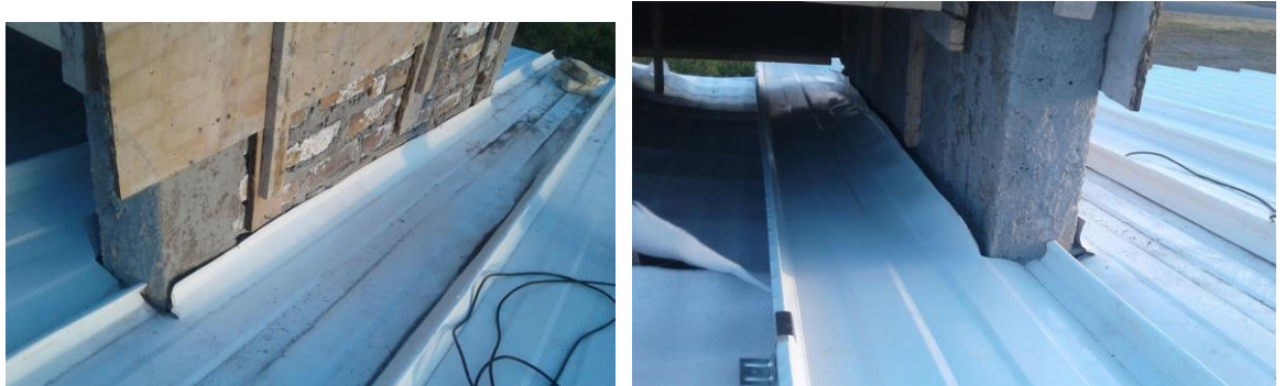
Figura 43. Mala terminación de la unión chapa estructura y ausencia de sellado para evitar la infiltración de agua.
