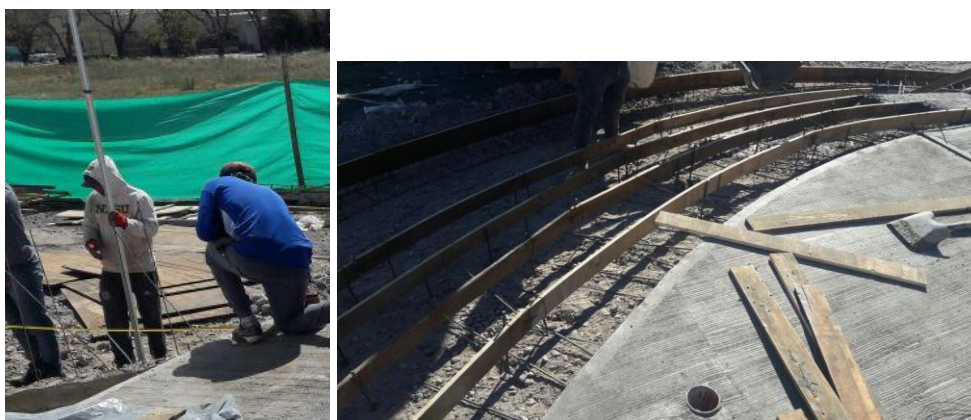
Figura 24. Replanteo Escalinata.
