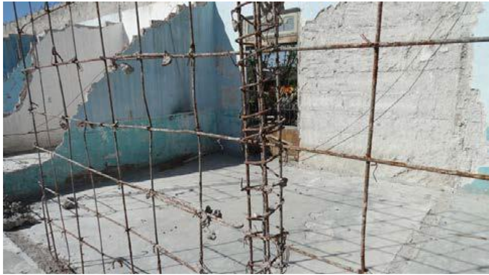
Figura 15. Armadura de muros.
