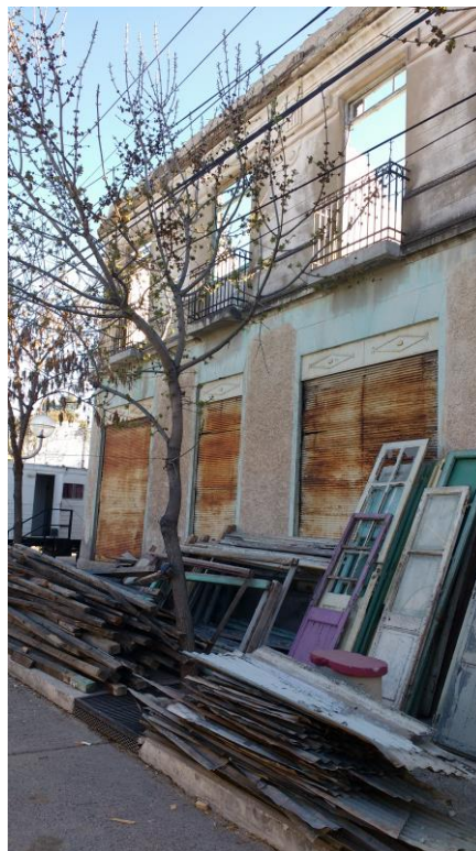
Figura 8. Retiro de carpintería para restauración.
