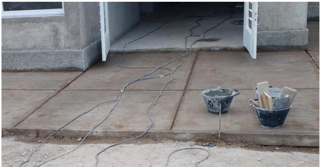
Figura 38. Terminación correcta de veredines
