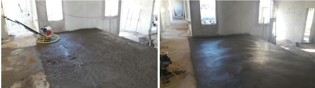
Figura 32. Llaneado con helicóptero.
