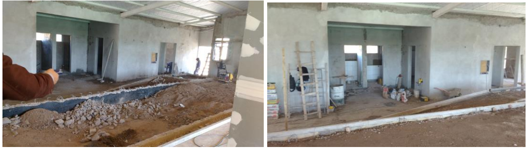
Figura 29. Relleno y compactación.
