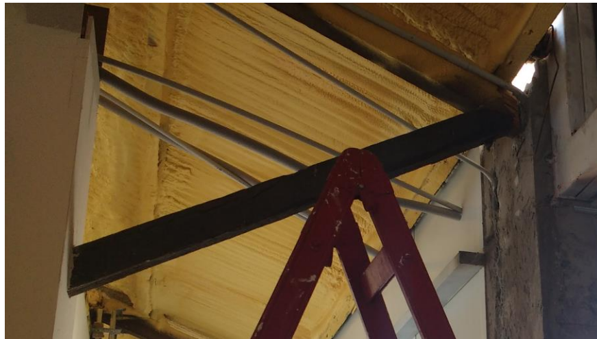
Figura 42. Deficiente sellado en unión de bloques constructivos.
