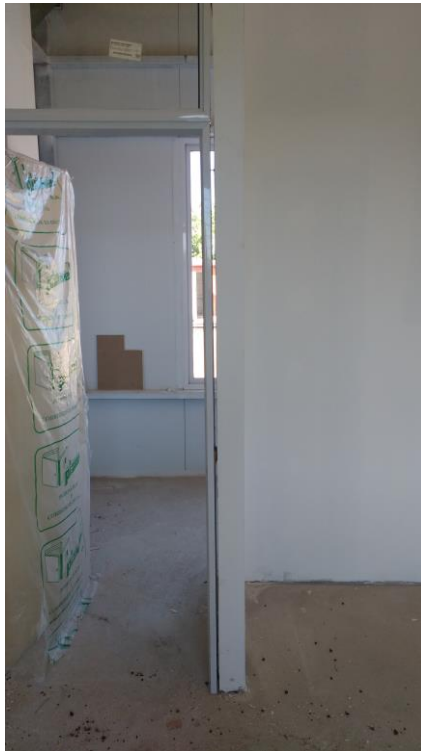
Figura 40. Incorrecto armado de marco de puertas.
