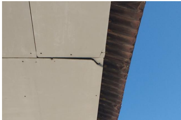
Figura 36. Rotura placa de alero exterior.
