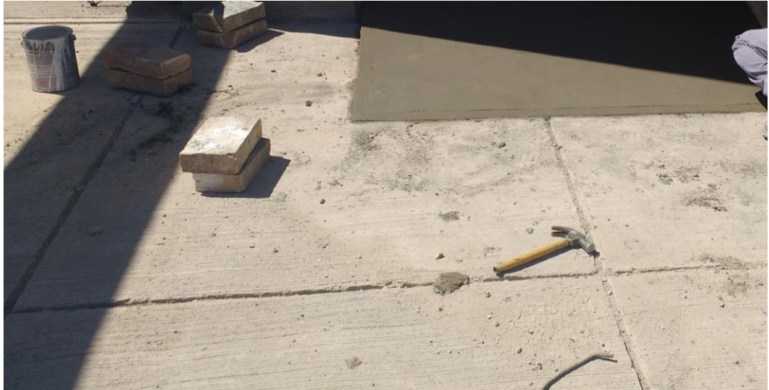
Figura 37. Mala terminación de veredines.
