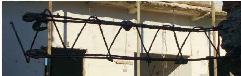
Figura 16. Armadura de viga existente.
