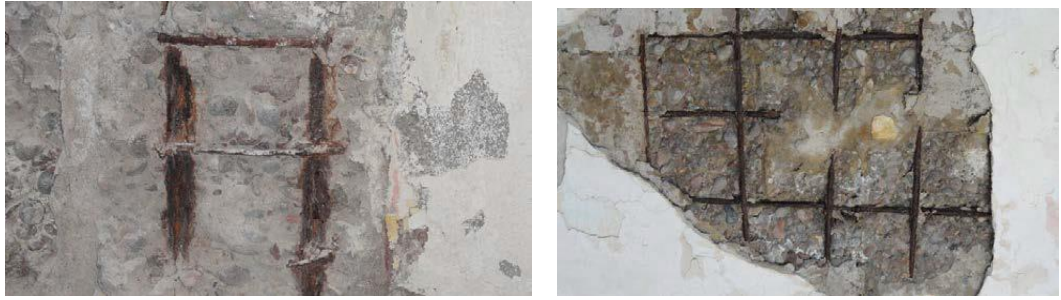
Figura 18. Severa corrosión de armaduras.
