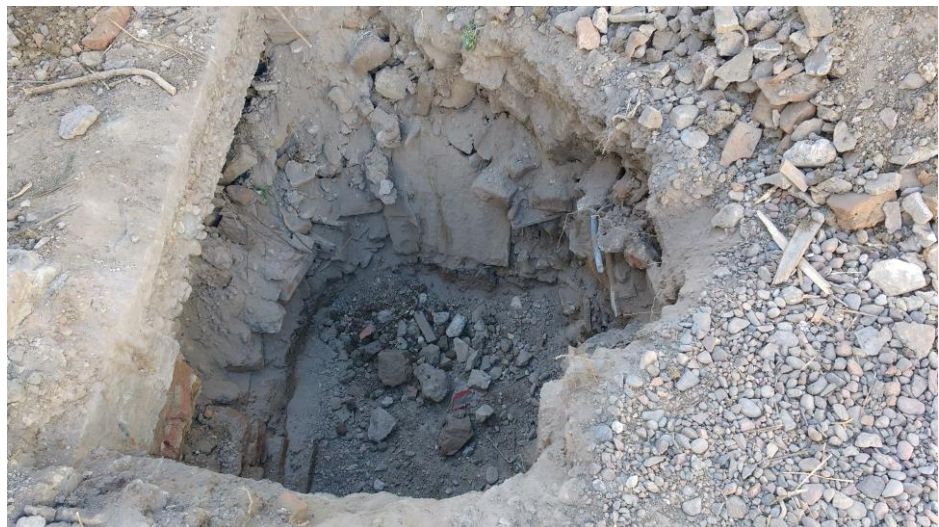
Figura 14. Desmoronamiento de cimientos.
