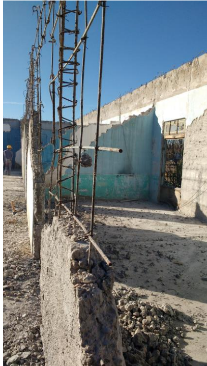
Figura 9. Demolición muros planta alta.
