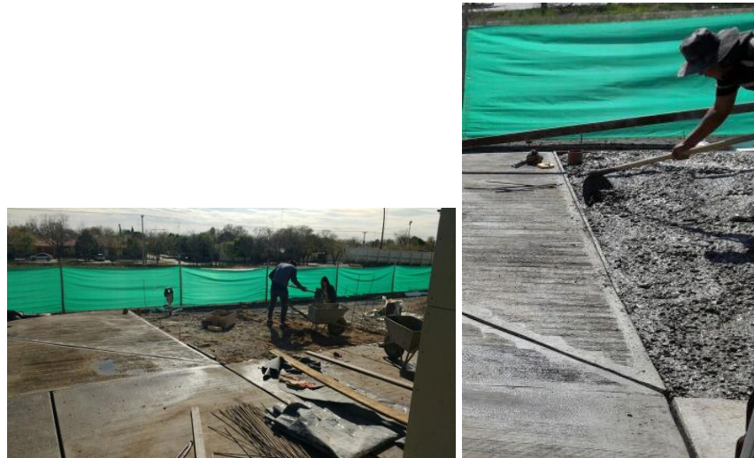
Figura 30. Hormigonado escalinata.
