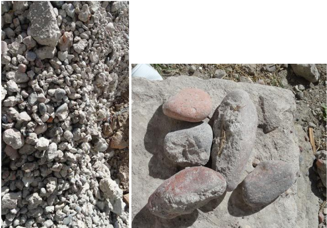
Figura 19. Falta de cohesión de agregados y grandes variaciones en tamaño de agregados.
