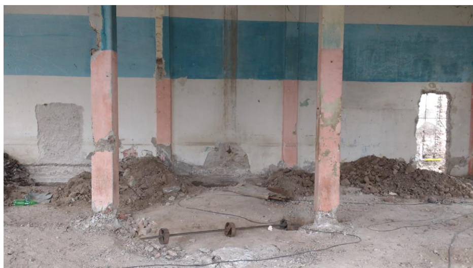
Figura 11. Excavación de Fundaciones.
