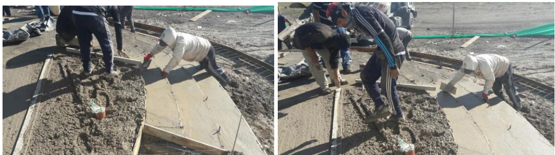
Figura 31. Regleado y alisado después de hormigonado.
