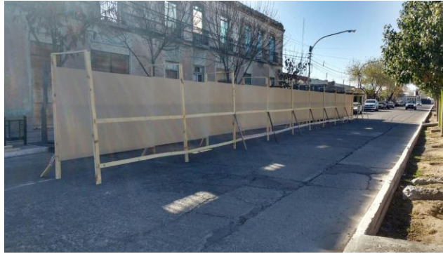
Figura 4. Construcción Cierre de obra.
