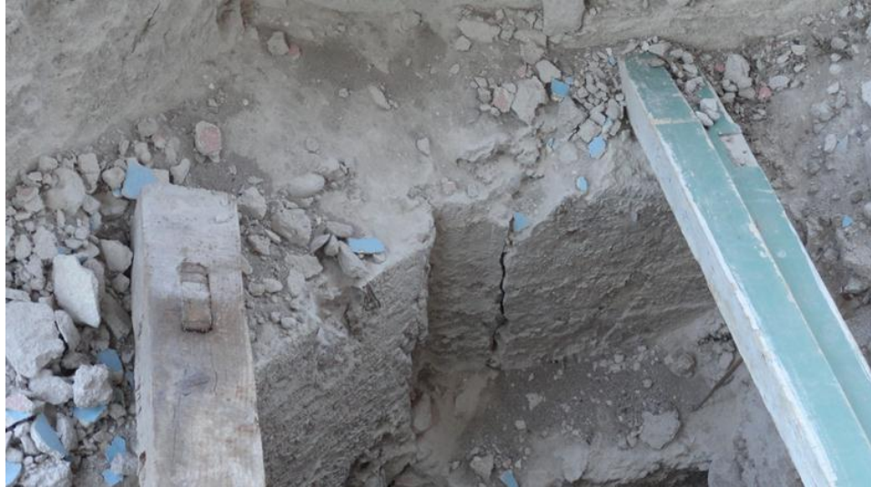
Figura 12. Fisura en fundación de muro de fachada.
