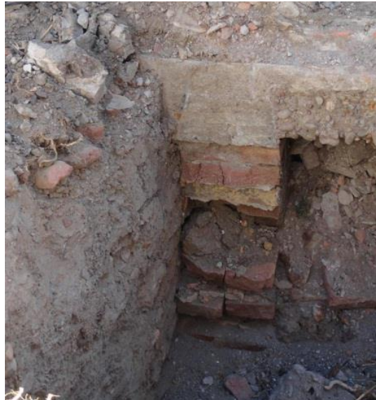
Figura 13. Cimientos de mampostería.
