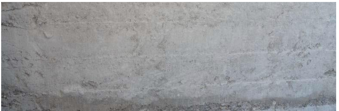
Figura 20. Juntas constructivas entra las distintas capas de colado de hormigón. Además, el Ing. Tornello realizo pruebas de esclerometría distintos puntos de la construcción como se observa en la figura 21, obteniendo los resultados de la figura 22.
