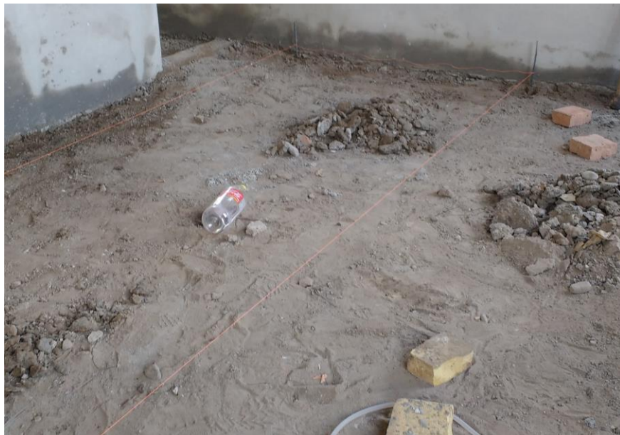
Figura 26. Colocación de tanzas guía para nivelar contra piso.
