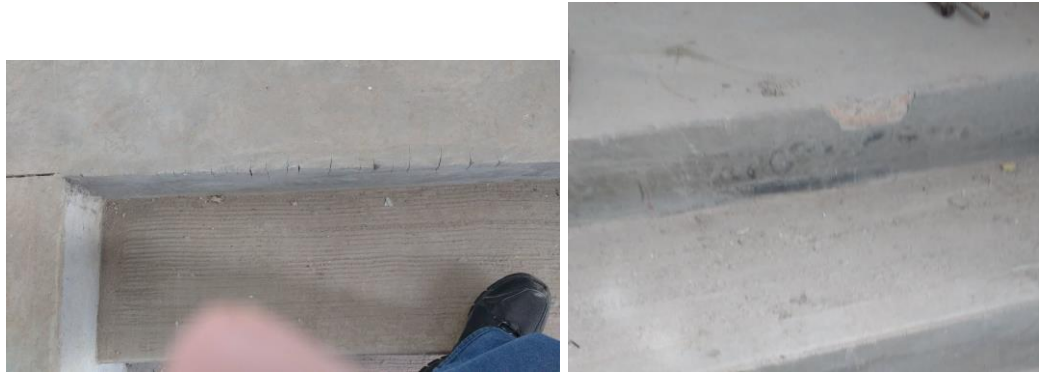
Figura 41. Agrietamiento y desprendimiento en bordes de escalera.
