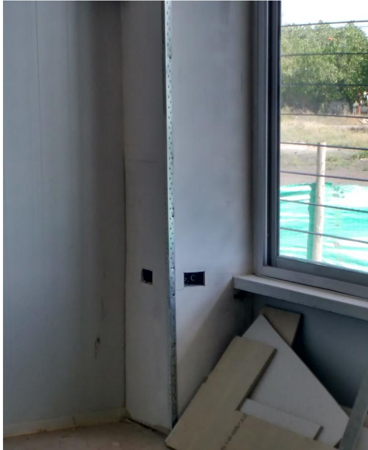
Figura 39. Tabiques de durlock alabeados.
