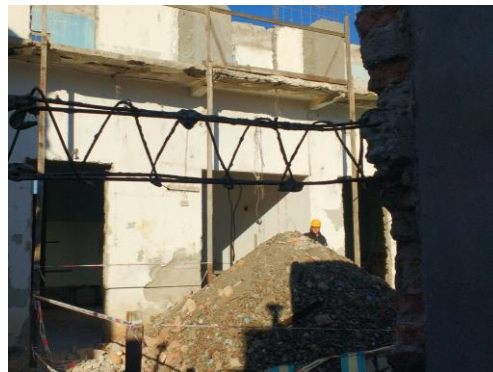
Figura 10. Acumulación de escombros para posterior retiro.
