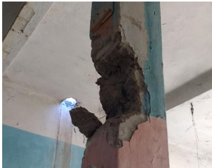
Figura 17. Columna existente con exceso de recubrimiento.
